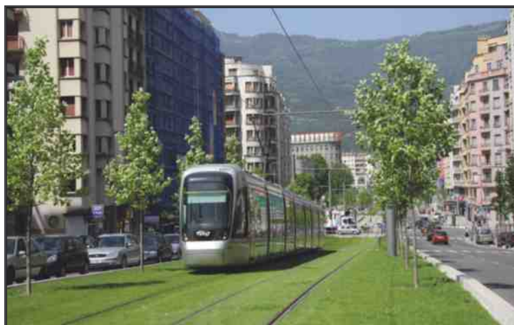
La plate-forme engazonnée du tramway de Grenoble
