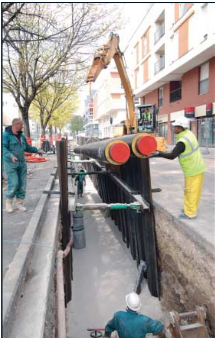
Installation du réseau de chaleur devant Junot, avenue du Drapeau à Dijon.
